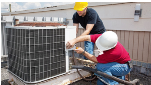
Услуги по монтажу инженерных систем
